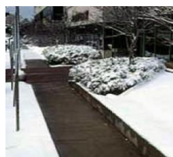
primer grejne instalacije ispod trotoara i stepeništa i njena funkcija
