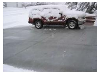
Primer grejnog sistema u radu koji deluje ispod površine na parkingu
